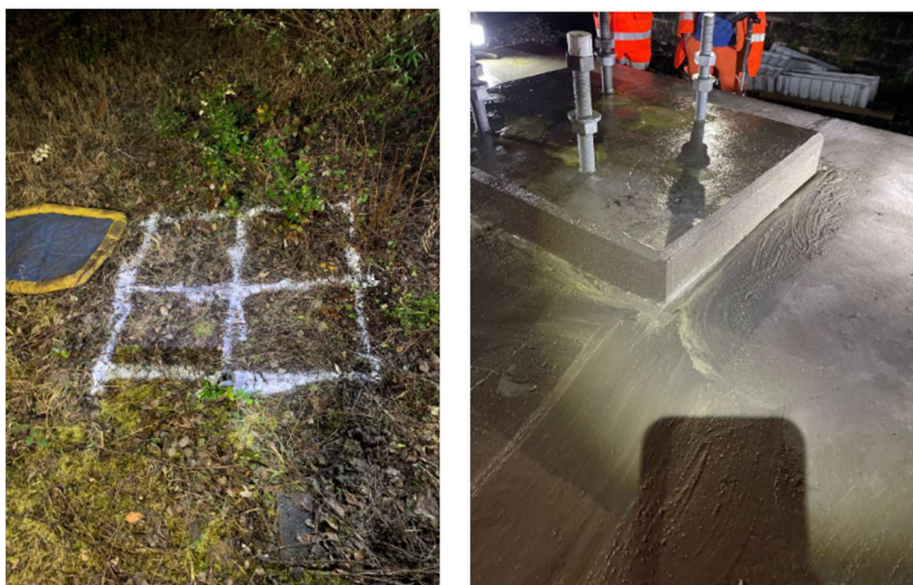
Figwr 7-2: Gosod sylfeini a mastiau / strwythurau cynnal i baratoi am drydaneiddio
